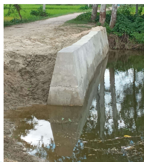
मिल पोखरीमा रिटैनिङ्ग वाल निर्माण
